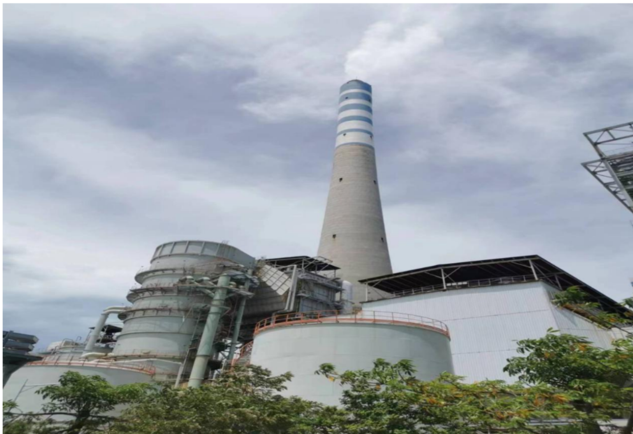
2023 年 7 月 3 日海南省乐东县莺歌海镇的国家能源公司乐东发电厂实景。
