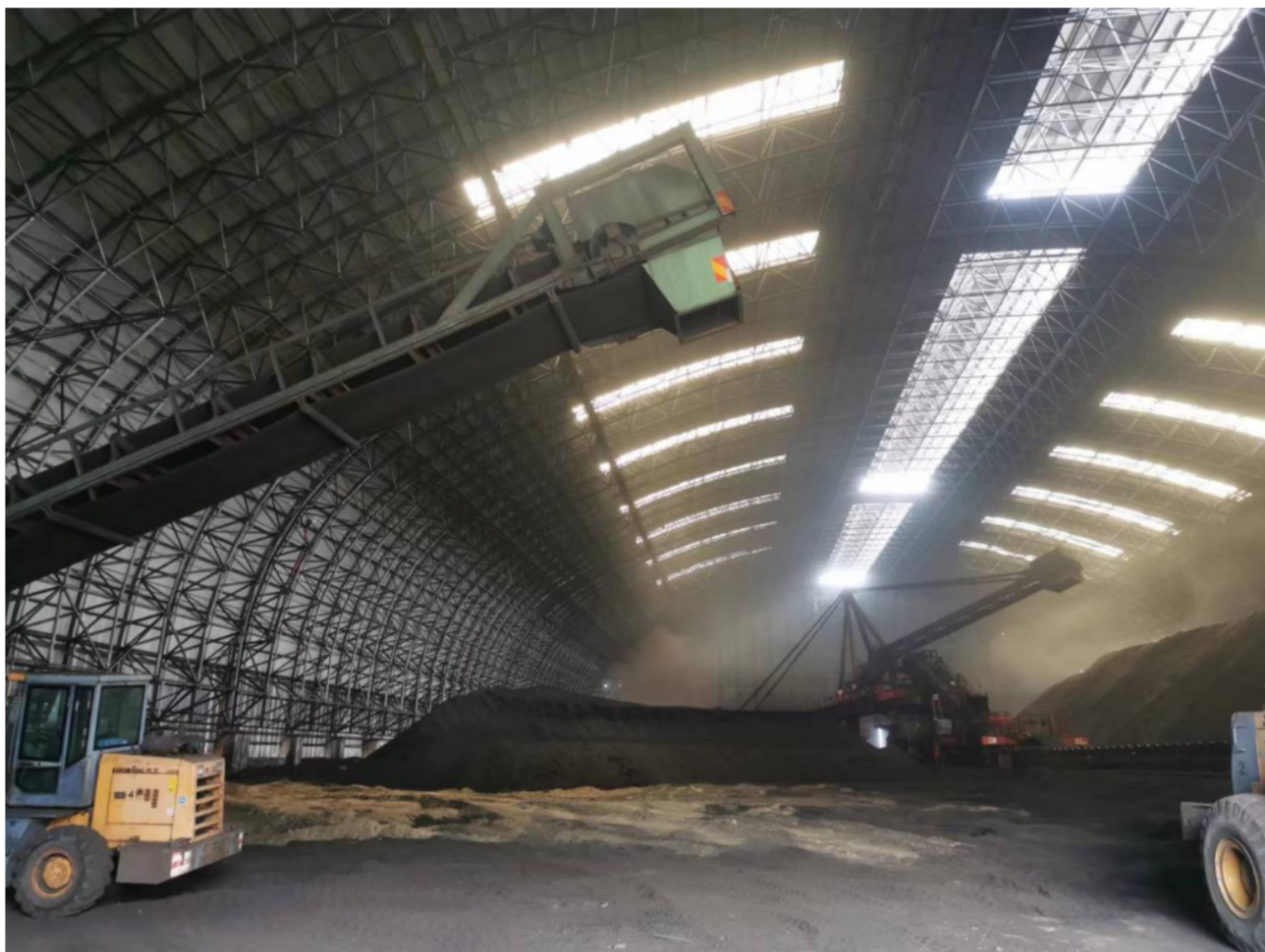
考察储煤仓库设施与进口褐煤的港口装卸条件。
